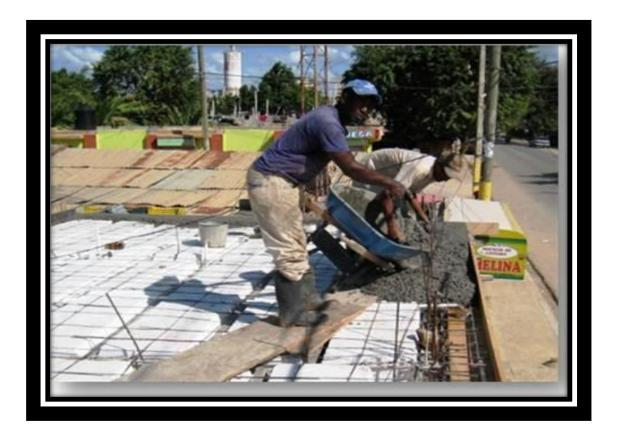
En el proceso de colocación del concreto se debe cuidar de no dañar la bovedilla colocando tablas entre las vigas para el tránsito.
