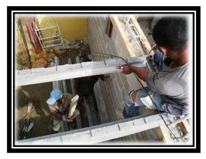
El sistema inicia con la colocación de las viguetas. El tipo de viguetas a emplear serán estabelcidas por el Ing. Estructural y dependerá de la longitud de los claros que comprenderá el plafón o losa asi como de la carga viva.
