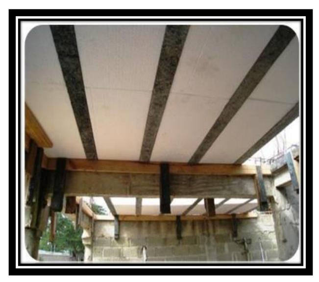
Vista del cielo raso empleando el sistema de viguetas de concreto y bovedillas de durapas instalado.
