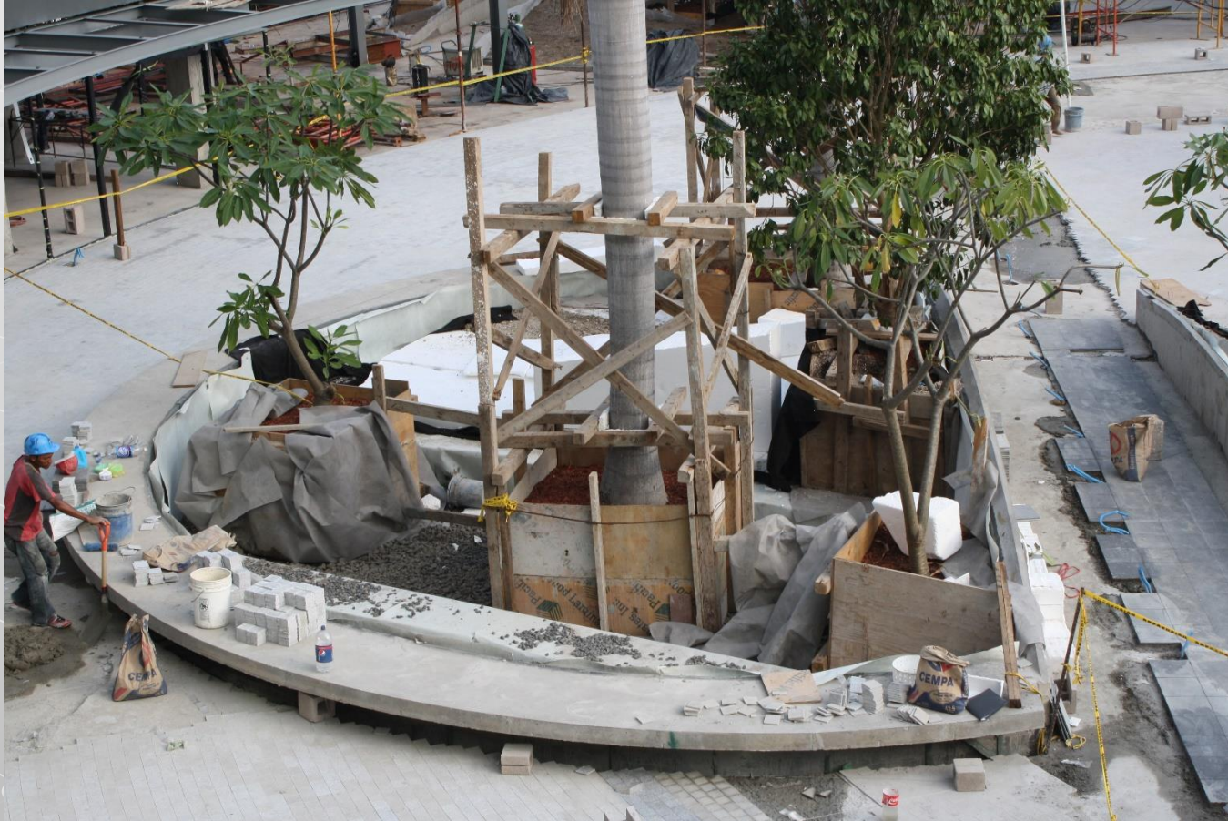
Torre Futura Relleno de Jardineras Pais: El Salvador
