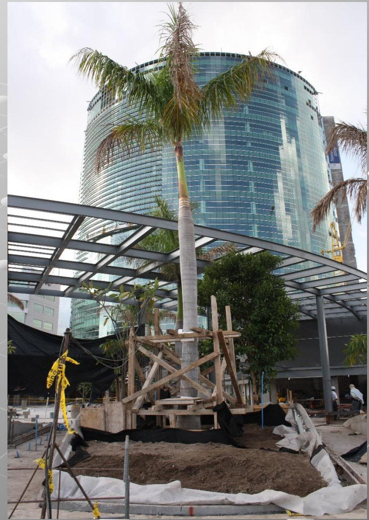
Torre Futura Relleno de Jardineras Pais: El Salvador
