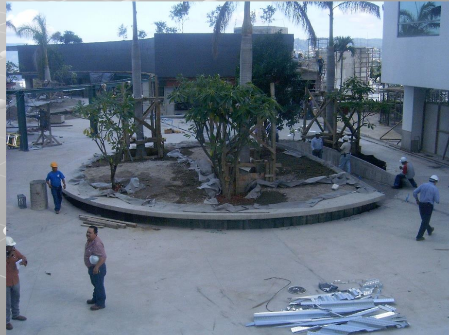
Torre Futura Relleno de Jardineras Pais: El Salvador
